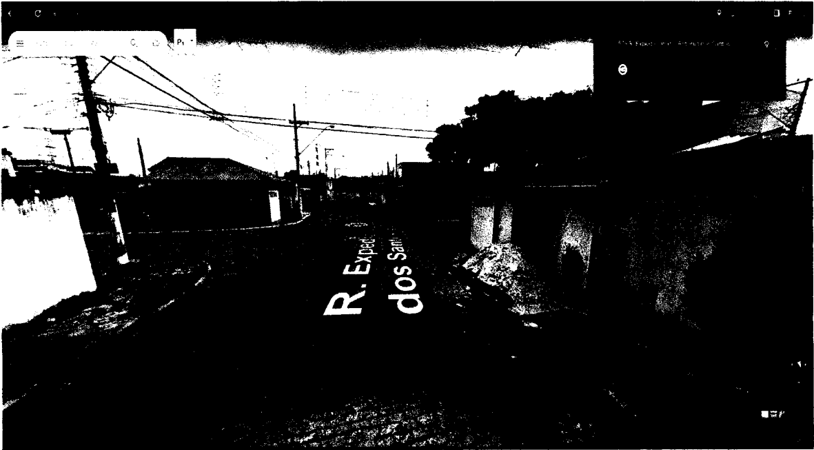
Substituição de rede de esgoto Rua Lucinda Barros com a Rua Expedicionário Antônio dos Santos Taboada - Jundiapéba, Mogi das Cruzes
